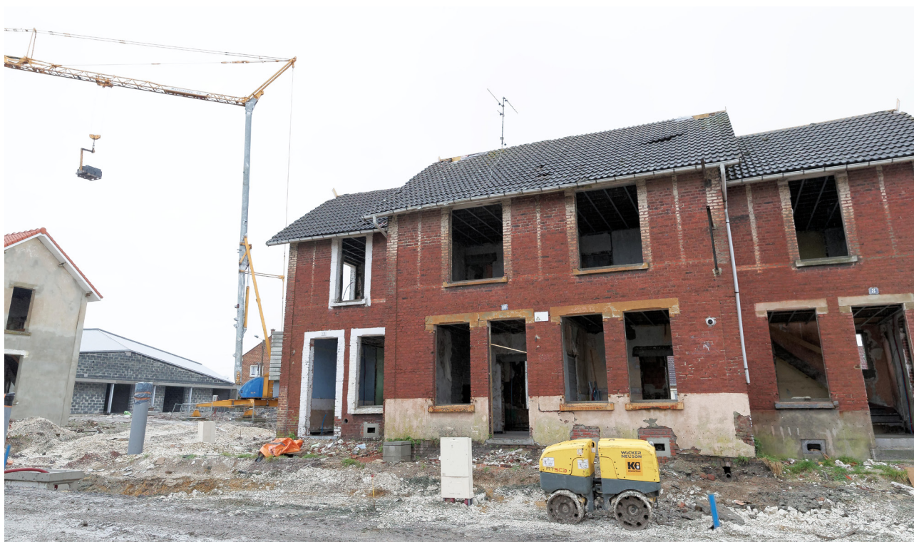
Chantier de rénovation à Lens (Pas-de-Calais).
